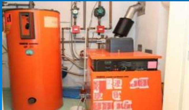
**Ölheizkessel Leistung 20kW**
